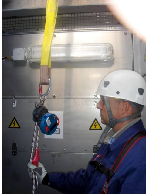
Accrocher le dispositif de descente d'urgence à un point d'ancrage prévu à cet effet.
